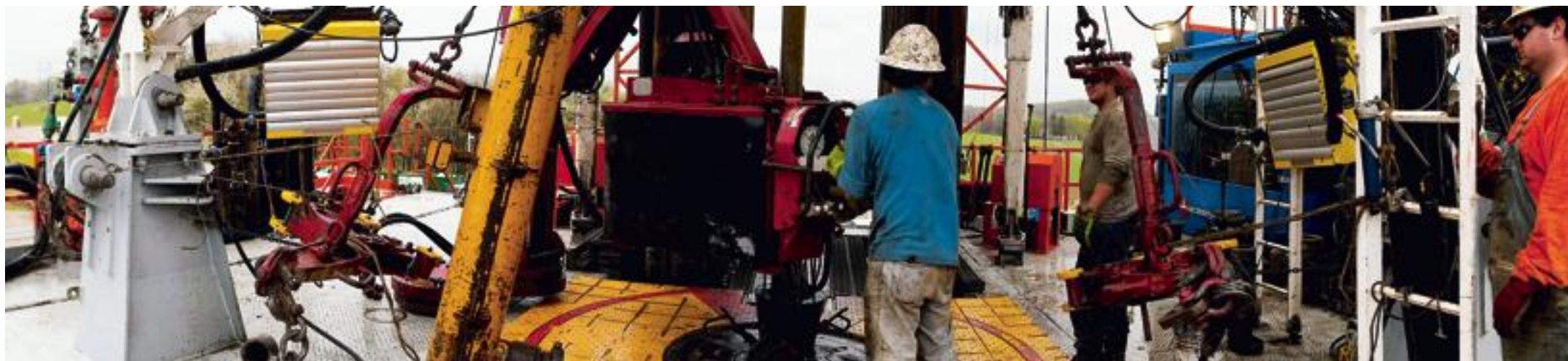
Un site de forage de gaz de schiste en Pennsylvanie, aux Etats-Unis. En France, la zone identifiée par Total, susceptible de renfermer du gaz de schiste, pourrait, selon le groupe, en contenir jusqu'à 2.380 milliards de mètres cubes.
